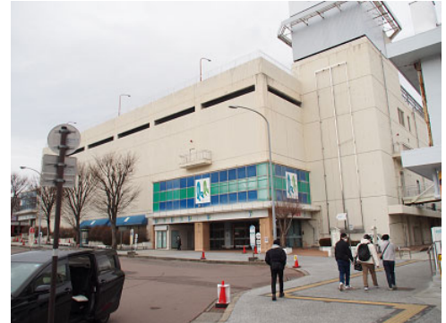
岡谷駅前再開発ビル
