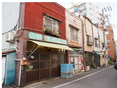
長屋建ての看板建築
