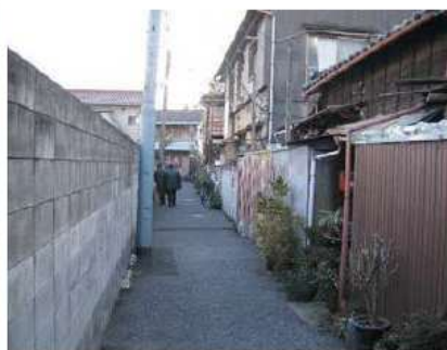
写真②：B路線整備前（北側から見たところ）
