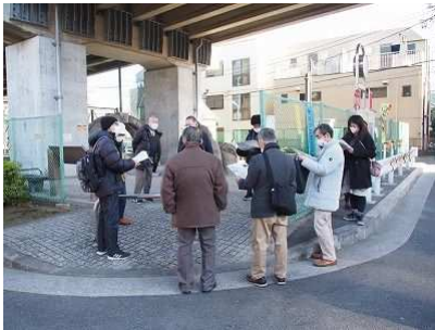
2 階建ての南橋 1階は崖下から崖上の十条地区へ 2階はJR線を越して十条地区へ
