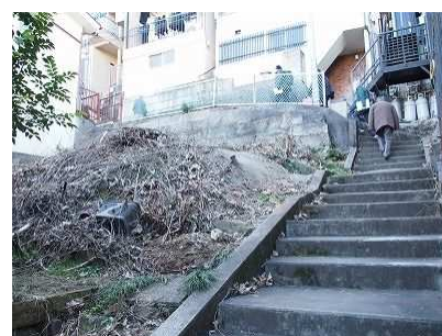
階段の途中に空き地、建替ができずうち捨てられていく
